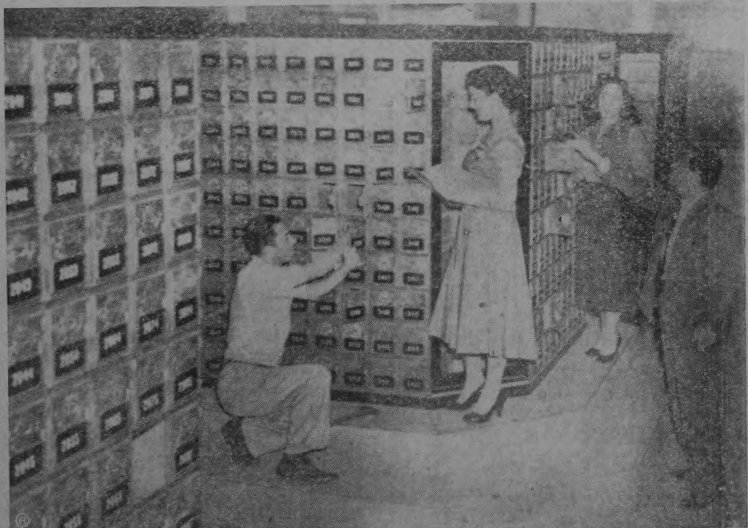
NUEVOS APARTADOS.—El Director de Correos, don Manuel A. Quirós, dirige las labores finales de instalación de los nuevos apartados que estarán listos a fines del presente mes. Son varios miles de nuevos casilleros, contruidos cuidadosamente y de acabado magnífico.—(FOTOCARRILLO).
